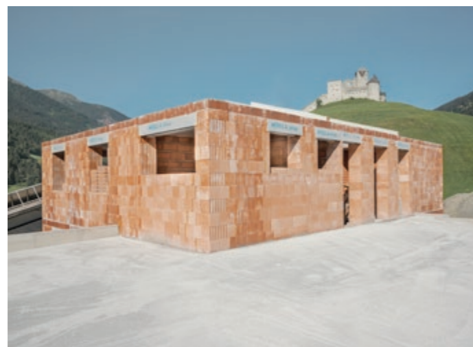
Budowa i remont
